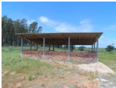
Ecoponto 2 - Fundos da Escola Municipal de Ensino Fundamental Francisco GiulianI
